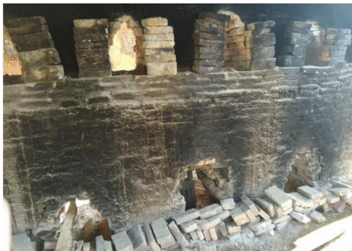
Gambar 5. Proses pembakaran batu bata
